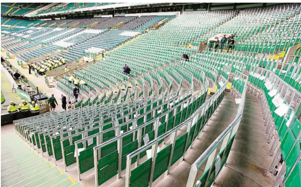
Il settore con i seggiolini reclinabili del Celtic Park di Glasgow: uno dei modelli possibili
